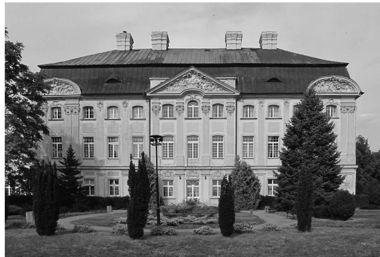
12. Pałac w Ciążeniu, elewacja ogrodowa, 2017. Fot. T. Bernatowicz
